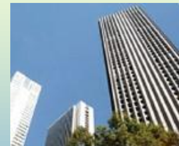
ビルメンテナンス
